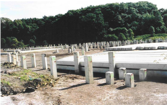
Fig. 6. Building site (AUCHAN Commercial Centre).
