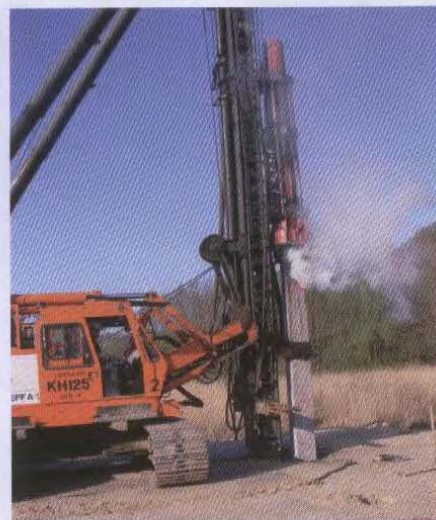
Fot. 3. Instalacja pala prefabrykowanego o długości 43 m – estakada E w ciągu obwodnicy Międzyzdrojów. Projektant: mgr inż. Wiesław Zawada, Transprojekt Gdańsk
