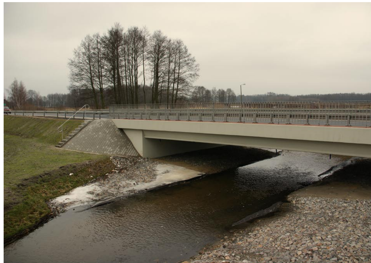
Fot. 1. Widok zbudowanego mostu
