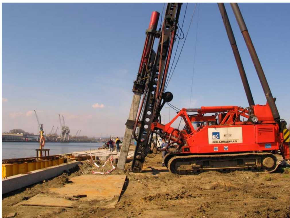
Rys. 5. Wbijanie pali prefabrykowanych 40x40 cm pod nabrzeże Obrońców Westerplatte w Porcie Gdańsk
