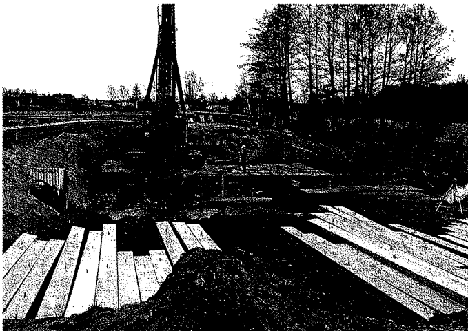
Rys. 6. Palowanie zasadnicze – most w Modrzejowicach
